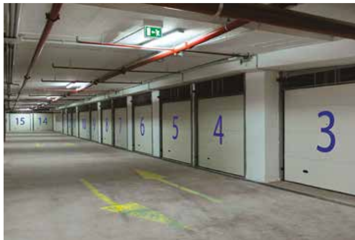
Applicazione dei numeri identificativi, in acciaio verniciato Coated-steel ID number application
